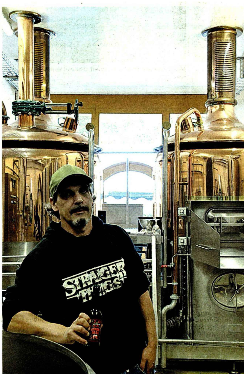
Roger Kündig an seiner Wirkstätte in der Brauerei Kündigbräu, in der Hand die dies-jährige Neukreation «Schwiirig Bier». Im Hintergrund die markanten Kupferkessel, in die Sudpfanne, Läuterbottich und «Whirlpool» eingebaut sind.
