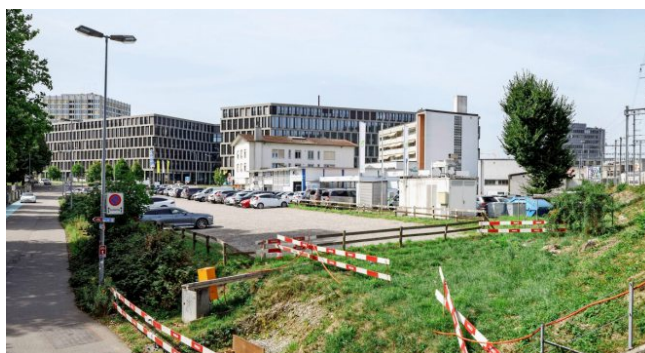
Auf diesem Kiesplatz entsteht die Gassenküche. Bild: Severin Bigler
